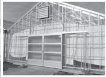
鉄骨ビニールハウス
