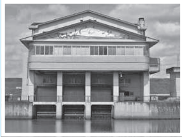
排水機场上屋
