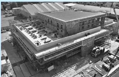
加須中央支店☆サイディング工事中 令和5年3月27日(月) オープン予定
