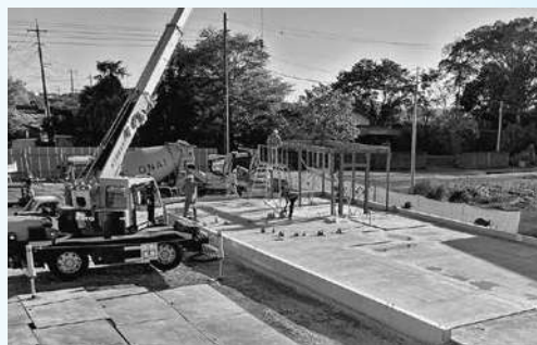
行田中部支店☆建て方工事中 令和5年2月27日(月) オープン予定
