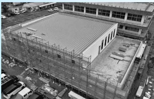
行田中央支店☆屋上防水工事中 令和5年2月27日(月) オープン予定
