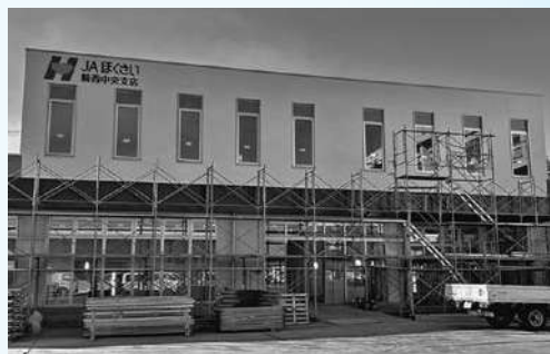
騎西中央支店☆外部コーキング工事中 令和5年1月30日(月) オープン予定
